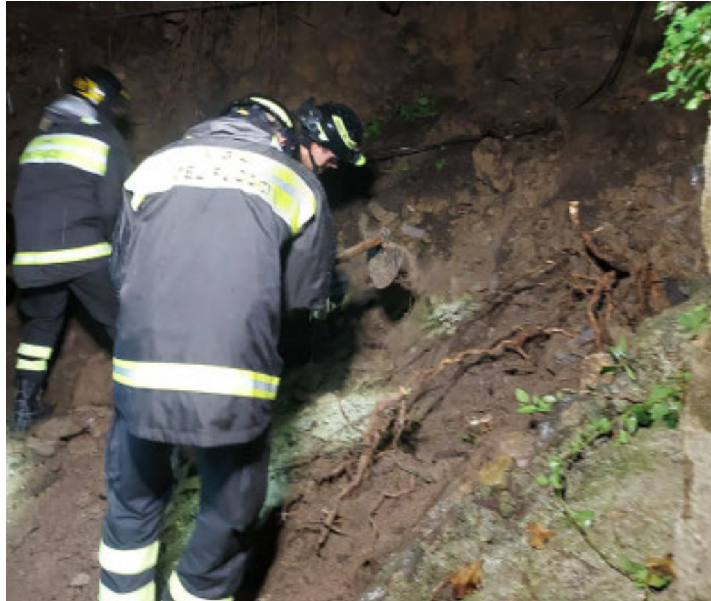
I vigili del fuoco al lavoro su frane e smottamenti
